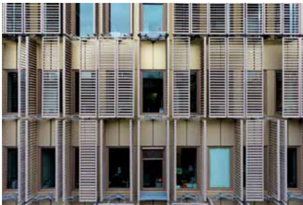
Des persiennes de mélèze servent de protections solaires aux fenêtres de cet immeuble de bureau.
