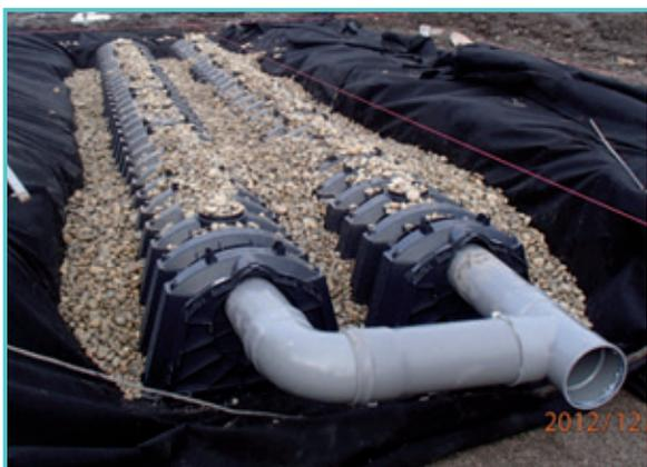
Structure tunnel. Porosité environ 70 %
