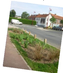
Exemple de Férin – 1 500 habitants lotissement La Petite Sensée 2007), noues plantées avec des massifs drainants : 11 500 m 2 infiltrés
