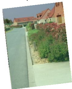
Exemple de Férin – 1 500 habitants lotissement La Petite Sensée 2007), noues plantées avec des massifs drainants : 11 500 m 2 infiltrés
