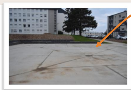
Des immeubles sont déconnectés du réseau d'eaux pluviales
