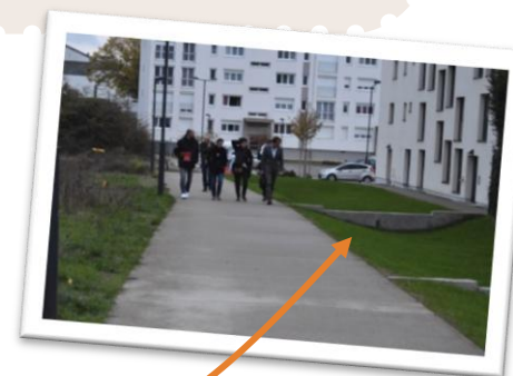
Présence de noues avec des redans pour favoriser l'infiltration des eaux
